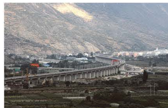
兰渝铁路白龙江三号特大桥
