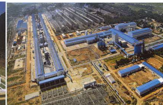
印度 Balco 铝厂 25 万吨 320KA 大型电解铝项目
