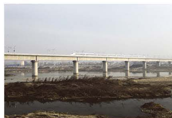
西成高铁汉江特大桥
