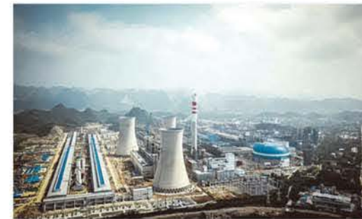
500KA 大型预焙电解槽工程 广西华磊项目
