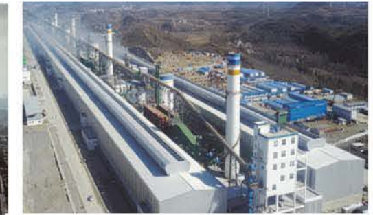
500KA 大型预焙电解槽工程 贵州华仁项目
